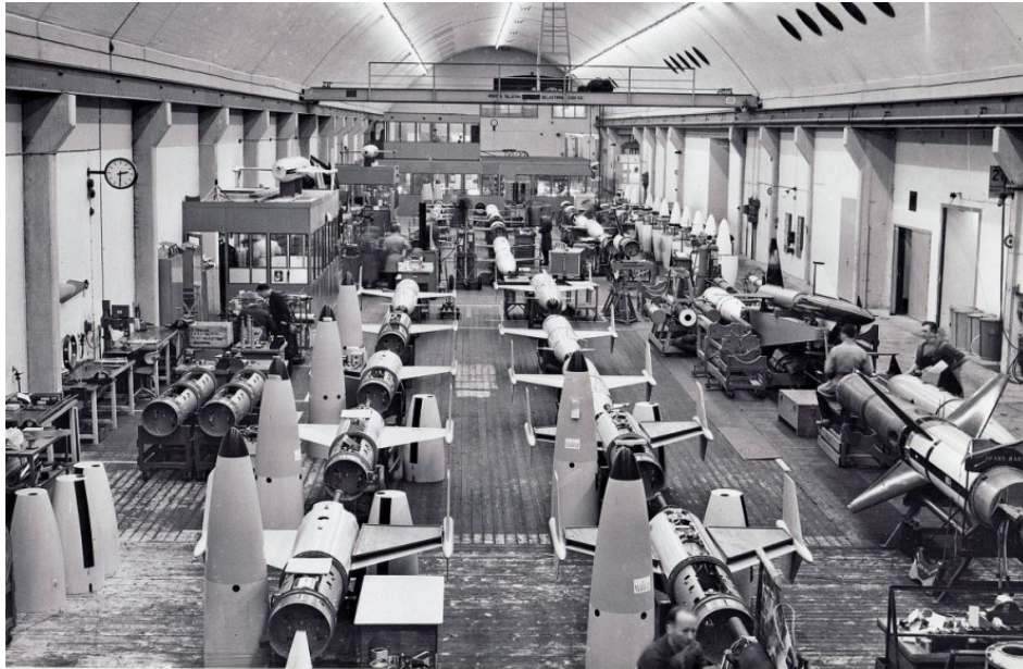
Tillverkning Robot 04 i tunnel 13.
