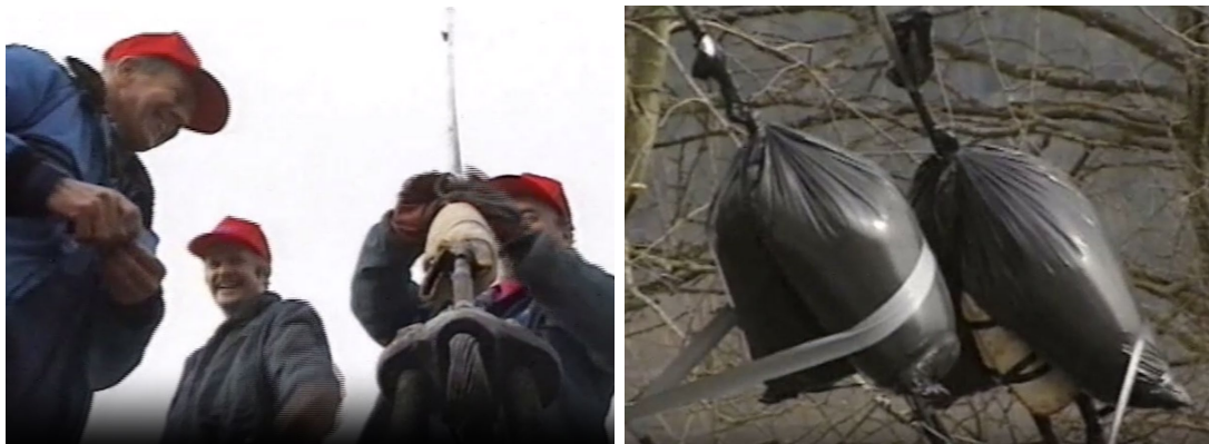
Sprängladdningarna fästes på två av staglinorna.
