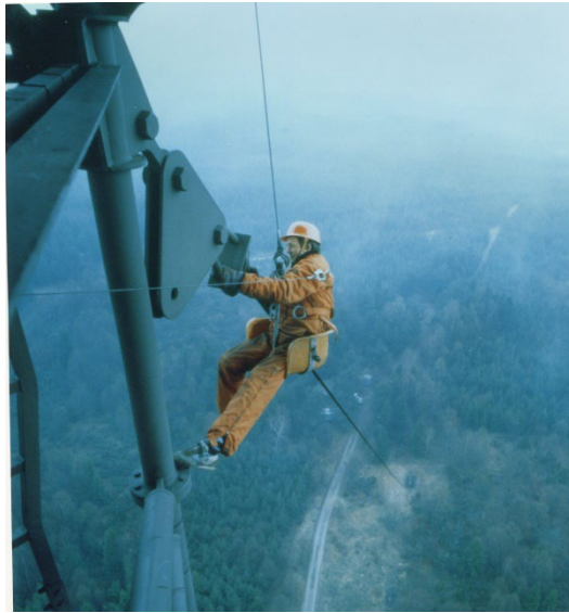
Hissen i masten. Ossian Möller CVA kontrollerar staglinor.
