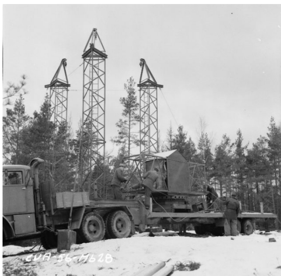
CVA installerar Radarstation PJ-21/F, till vänster radarn till höger höjdmätaren.
