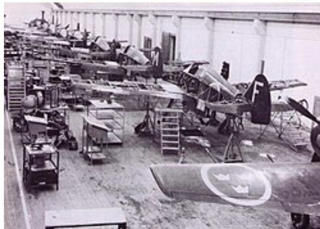
1946, J 22 under ombyggnation till S 22 i Arboga.
