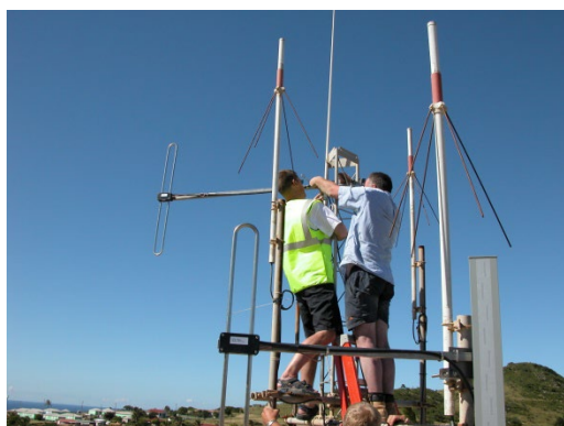
Hans Carlsson installerar antenner.
