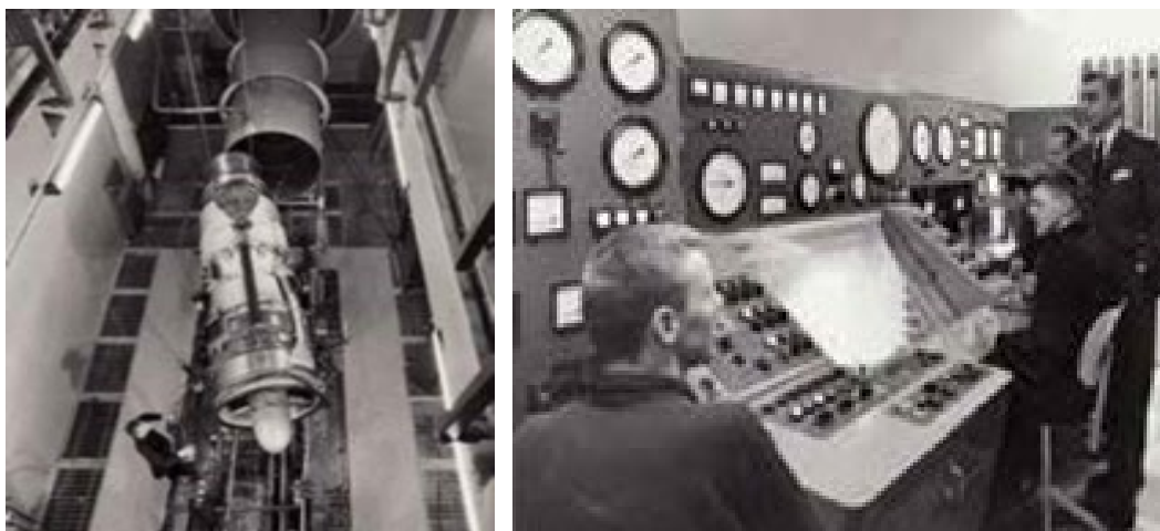
En av de första RM 6 motorerna för test
