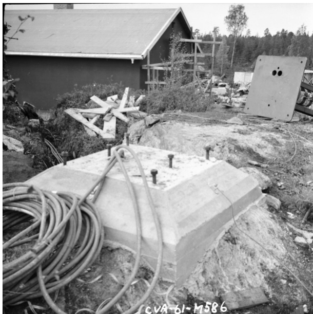
Antennfundament 1961
