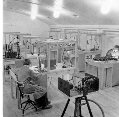
Kontroll av kursgyro och svängindikator 1947
