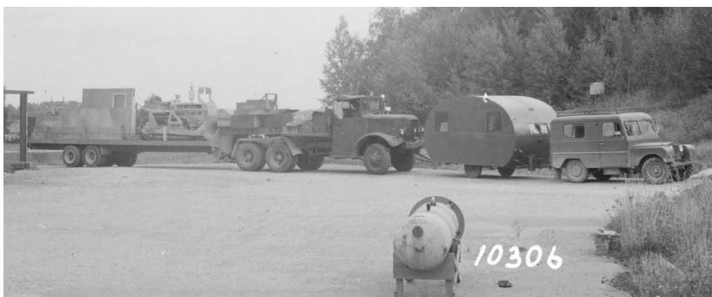
1953, ett arbetslag lämnar CVA för en RT-01 installation med bl.a. en jordlinetraktor
