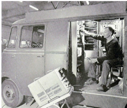
Installation av Servicebil 35 i By 6
