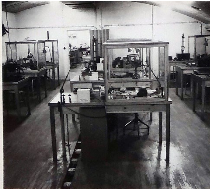
Gyro- och siktesverkstad med maskinverkstaden i bakgrunden 1949–1950
