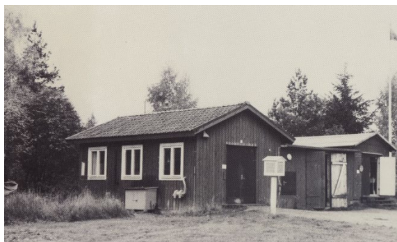
100m-skjutbanan. Byggnad 21A vid 1950-talets mitt
