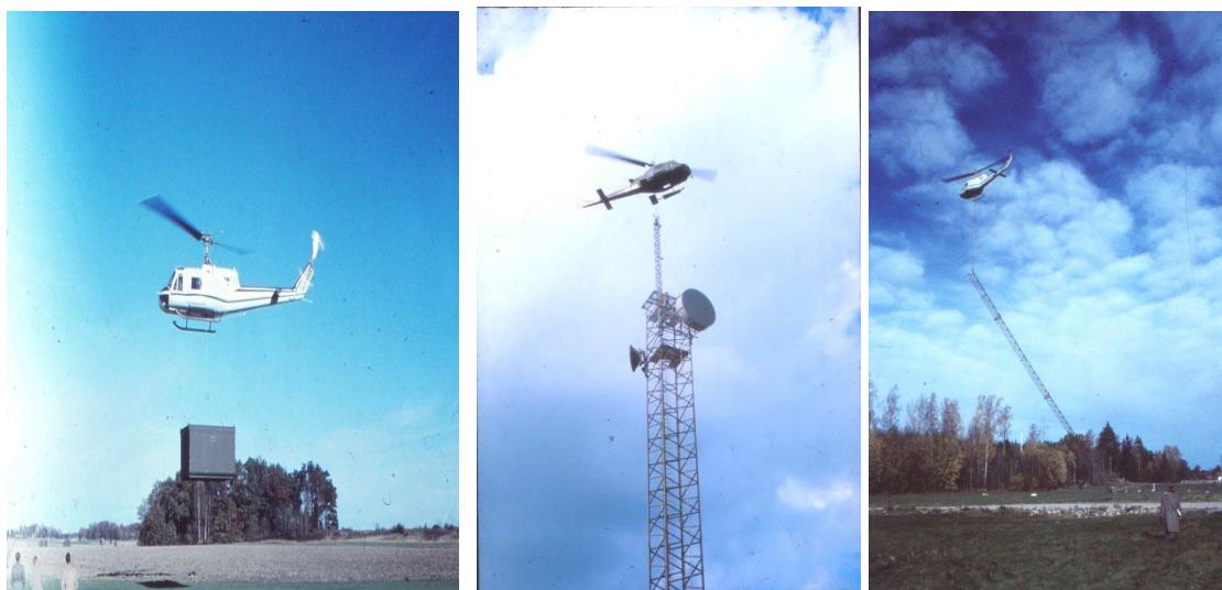
Exempel på helikopterlyft för radiolänk
