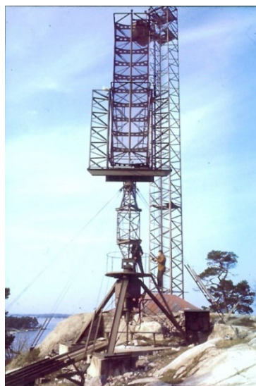
CVA installerar Radarstation PJ-21/F, till vänster radarn till höger höjdmätaren.
