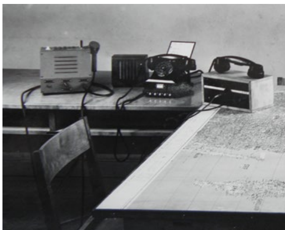
FMR-V installation på en stridsledningsanläggning, apparatrum och tidig manöverplats. FMR-V manöverpanel till vänster på den högra bilden
