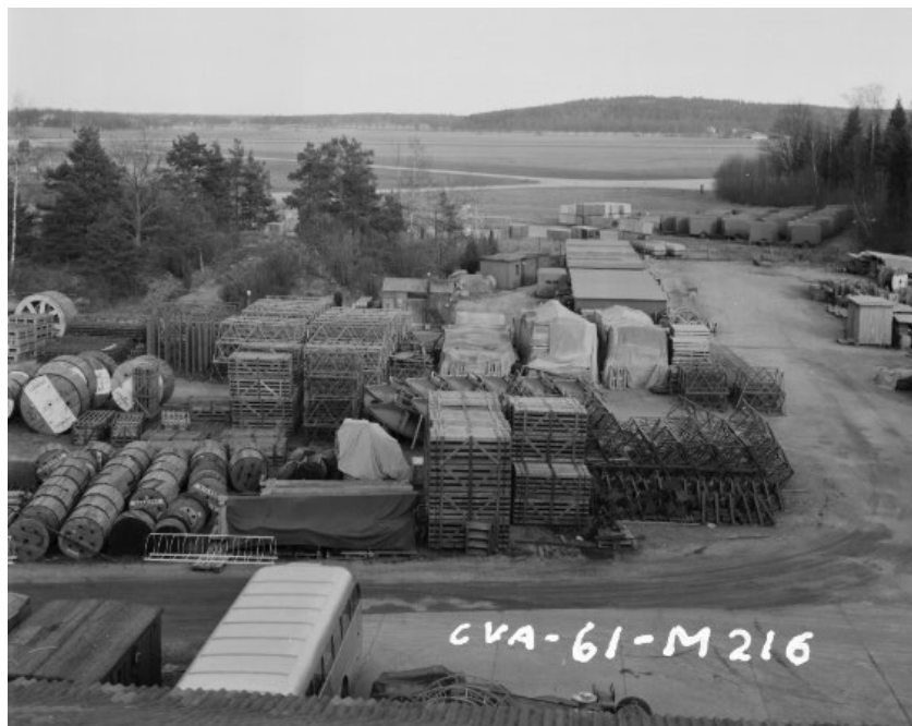
Uppläggningsplats "Stentippen" för installationsmtrl.
