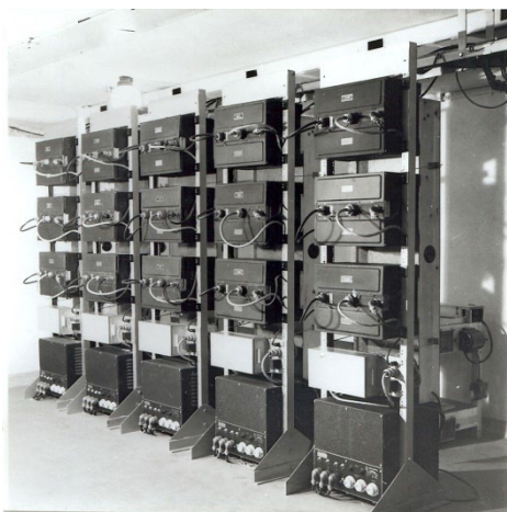
FMR-V installation på en stridsledningsanläggning, apparatrum och tidig manöverplats. FMR-V manöverpanel till vänster på den högra bilden
