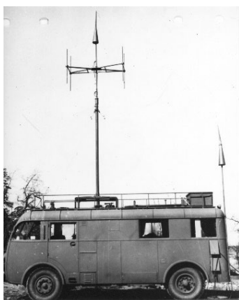
KPL-bil med FMRP-V pejl, radiostationer och manöverplats.
