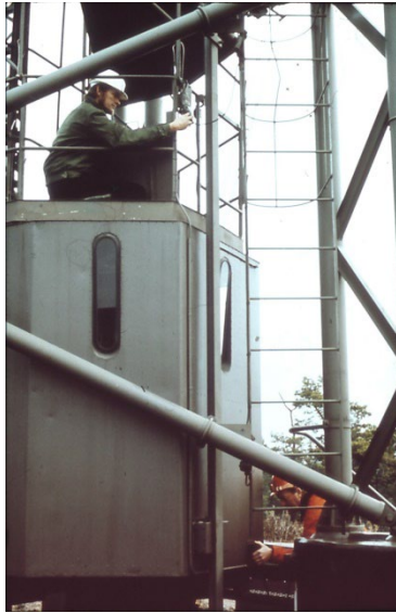
Hissen i masten. Ossian Möller CVA kontrollerar staglinor.
