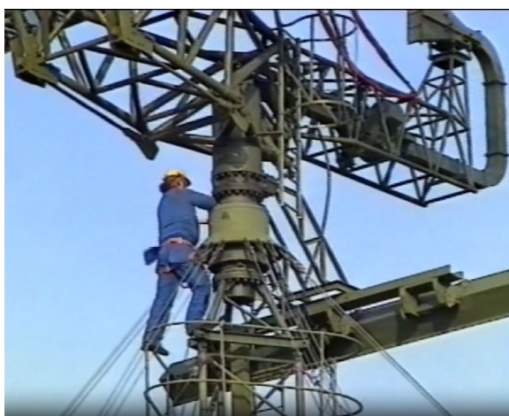
Installation av antenn
