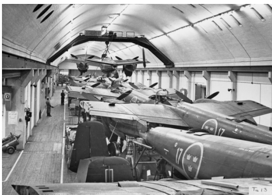
Modifiering av fpl B 18 i Tunnel 13.
